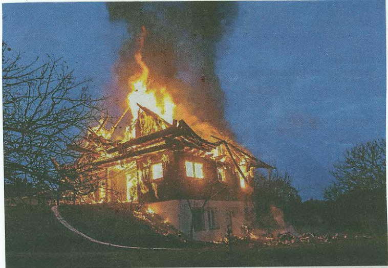
Das großteils aus Holz gebaute Haus brannte komplett nieder
